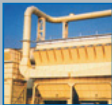
LHS-Reihenfilter für 165.000 m 3 /h
