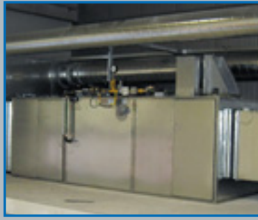
LHS-Zu-, Ab-, Umluftgerät mit Wärmerückgewinnung
